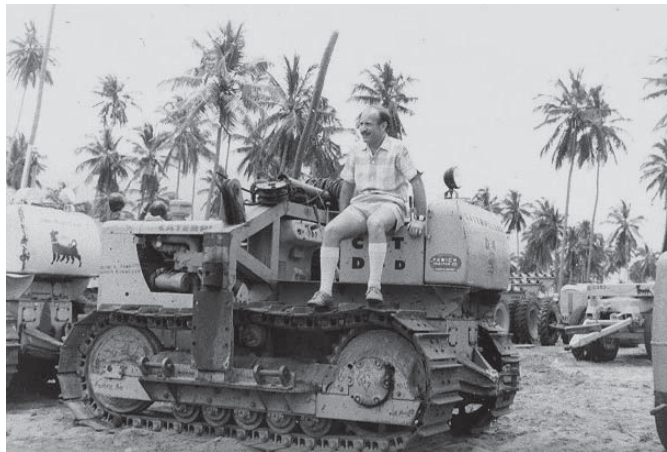
L'autore a bordo del trattore posatubi CAT D4, cantiere di Kurasini a Dar es Salaam, estate 1969.
